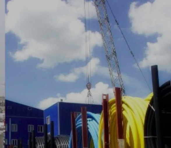
ПОДОЛЬСК, КЛИМОВСКИЙ ТРУБНЫЙ ЗАВОД
